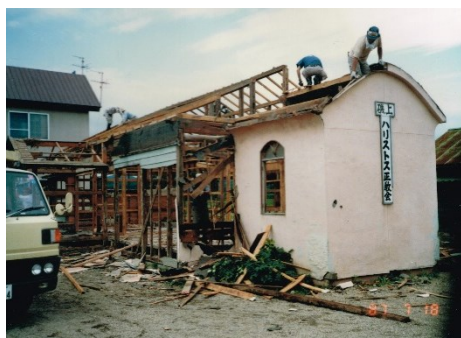
▲旧会堂の解体
