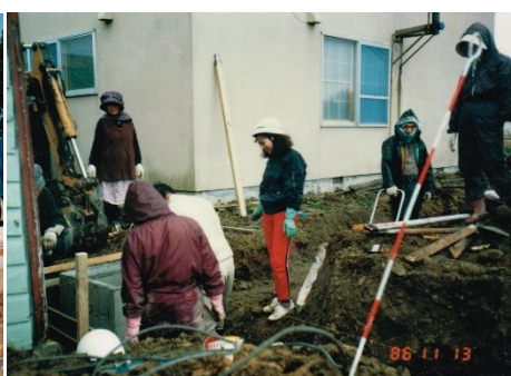
▲信徒の手弁当で協力した現聖堂建設
