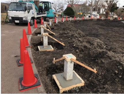
▲遊歩道のチェーン柵の復旧
