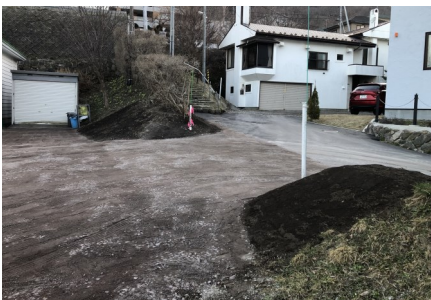
▲会館入口の盛土の復旧
