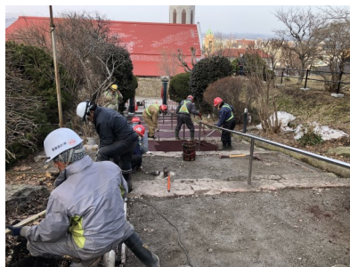
▲正門階段の整地舗装と外灯の更新
