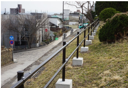
▲新たに設置されたガードパイプ柵
